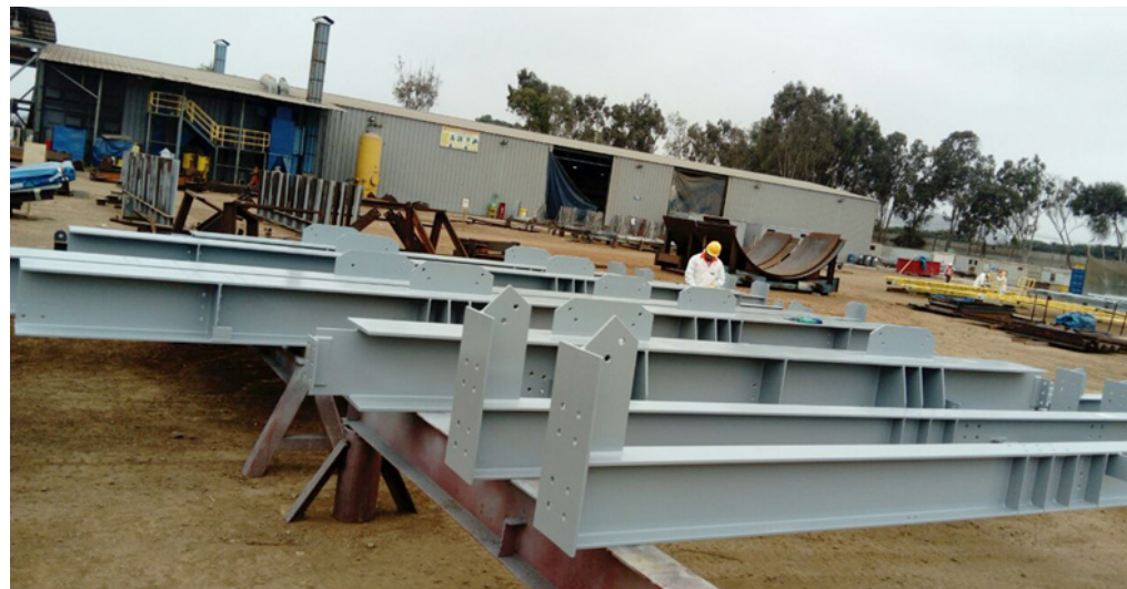
Soldeo de Silos
