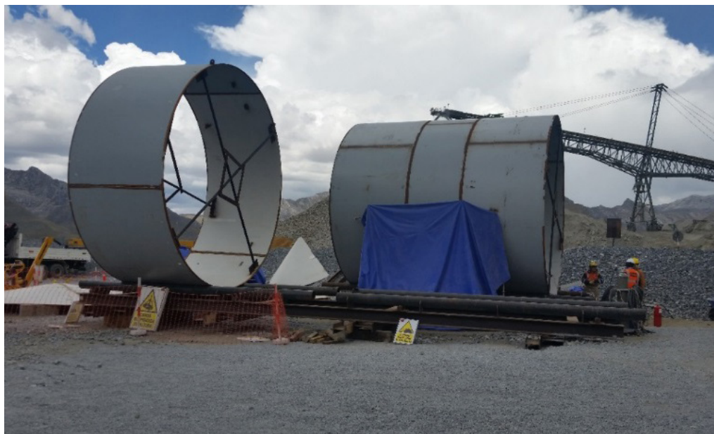
Montaje de Estructuras
